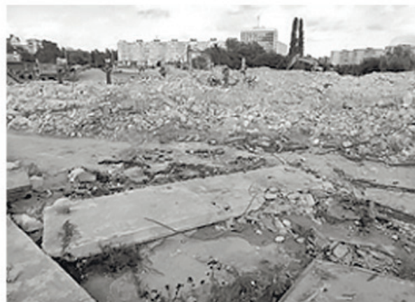
б) после демонтажа
