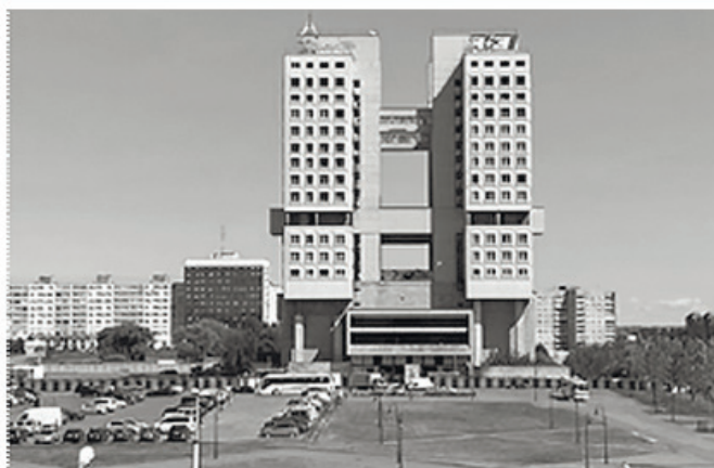
а) до демонтажа
