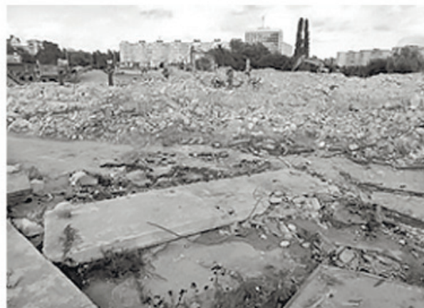
б) после демонтажа
